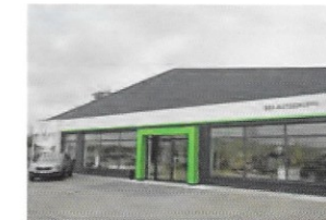
Schleiz Hofer Straße 58 C Tel. 03663 48450
