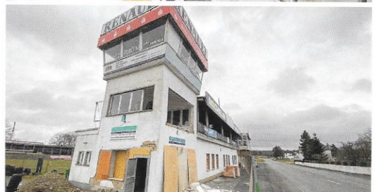
Während der Ausbauphase.
